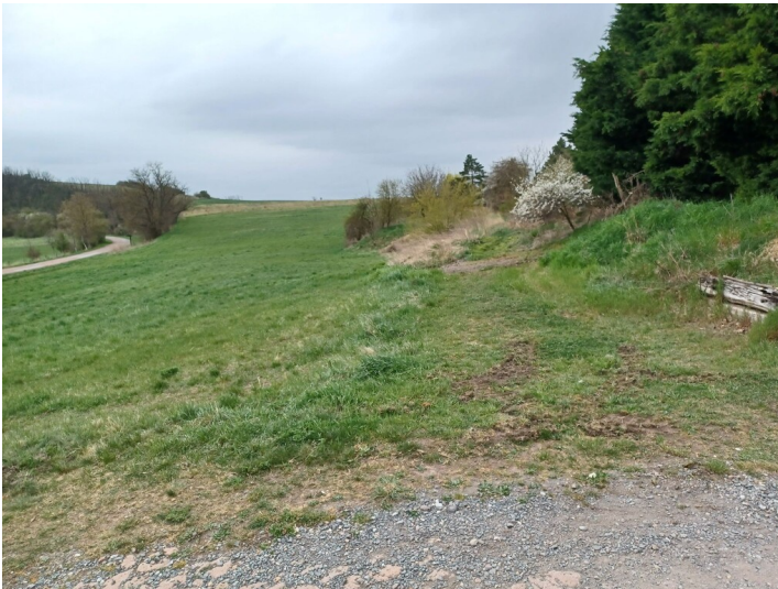
Bahnstrecke Teutschenthal-Salzmünde - Blick entlang der ehemaligen Trasse in Richtung Süden auf Höhe des Thaleweges in Zappendorf Fotograf/Urheber: NAME FEHLT
