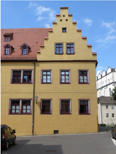
Oberbergamt Fotograf/Urheber: NAME FEHLT
