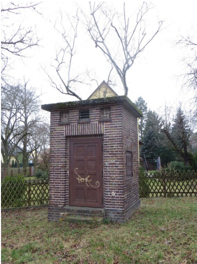
Transformator Fotograf/Urheber: NAME FEHLT
