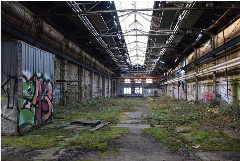
Reichbahnausbesserungswerk RAW Halle - Werkhalle Fotograf/Urheber: NAME FEHLT
