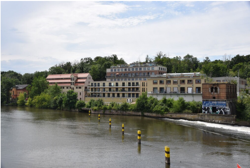
Papierfabrik Kröllwitz - Ansicht von der Saale auf die ehemaligen Papiermühle Kröllwitz Fotograf/Urheber: NAME FEHLT
