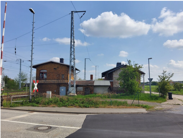
Stellwerk Teutschenthal 1 - Ansicht Poststraße/ Straße der Einheit Fotograf/Urheber: NAME FEHLT
