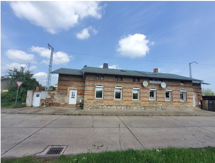
Wohngebäude Stellwerkswärter - straßenseitige Ansicht (Süd) Fotograf/Urheber: NAME FEHLT
