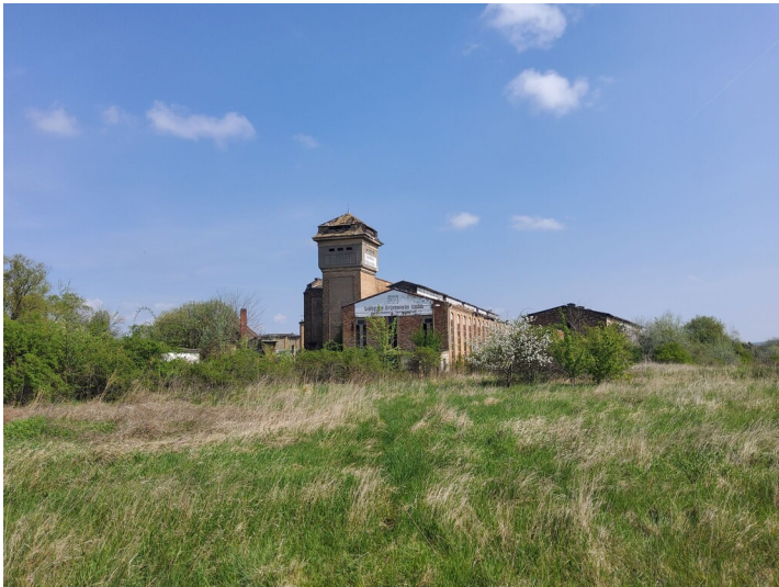
Walzwerk Teutschenthal Fotograf/Urheber: NAME FEHLT
