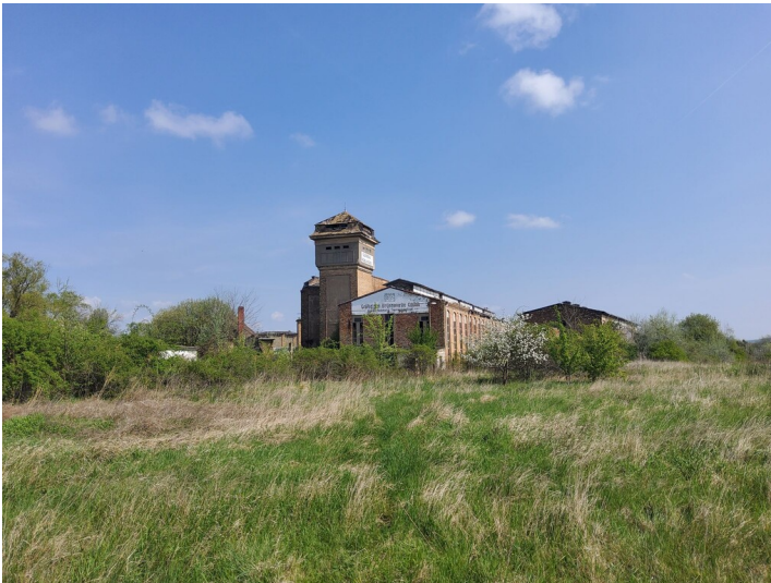
Walzwerk Teutschenthal Fotograf/Urheber: NAME FEHLT
