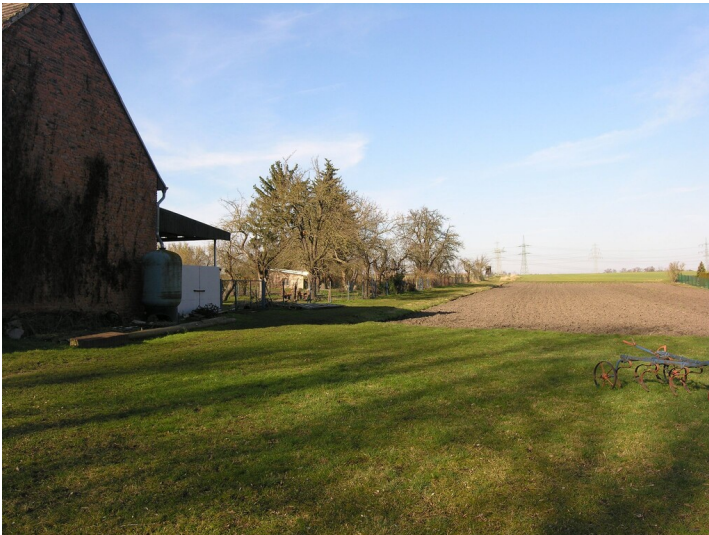
Schacht, Tagesanlagen und Fabrik (vor 1872-vor 1908) - Situation ehemaliger Tagesanlagen und Fabrik; Blick N Fotograf/Urheber: NAME FEHLT
