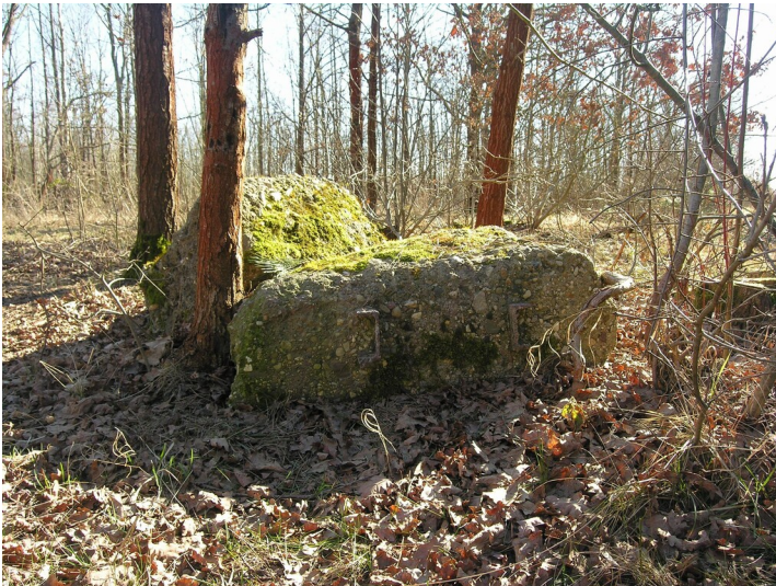
Tagesanlagen und Fabrik der Grube Goedecke (nach 1872-1955) - ausgebrochene Fundamentreste, Beton; Blick SE Fotograf/Urheber: NAME FEHLT
