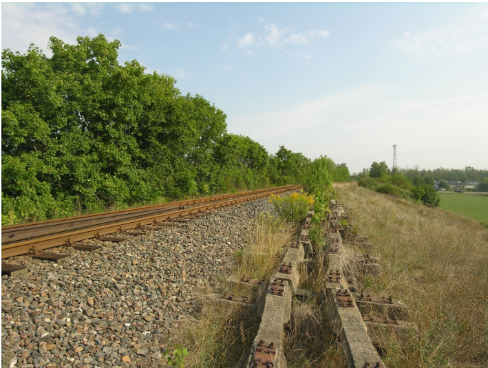
Erhöhter Eisenbahndamm in der Elsteraue (1928) - auf dem Bahndamm; Blick N Fotograf/Urheber: NAME FEHLT
