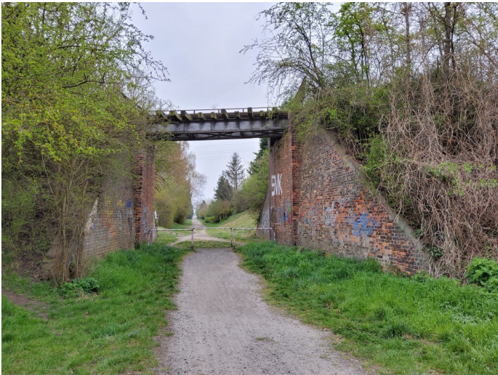
Brücke der Bahnstrecke Halle-Hettstedt - Blick nach Süden Fotograf/Urheber: NAME FEHLT
