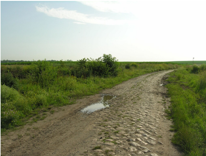
Werkstraße der Grube Eintracht (1850-1894) - die gepflasterte Straße zum Schacht; Blick E Fotograf/Urheber: NAME FEHLT
