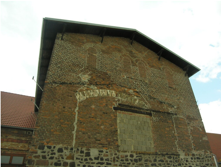
Zuckerfabrik Oppin - Gebäude der Zuckerfabrik, Detail einer Fassade; Blick W Fotograf/Urheber: NAME FEHLT
