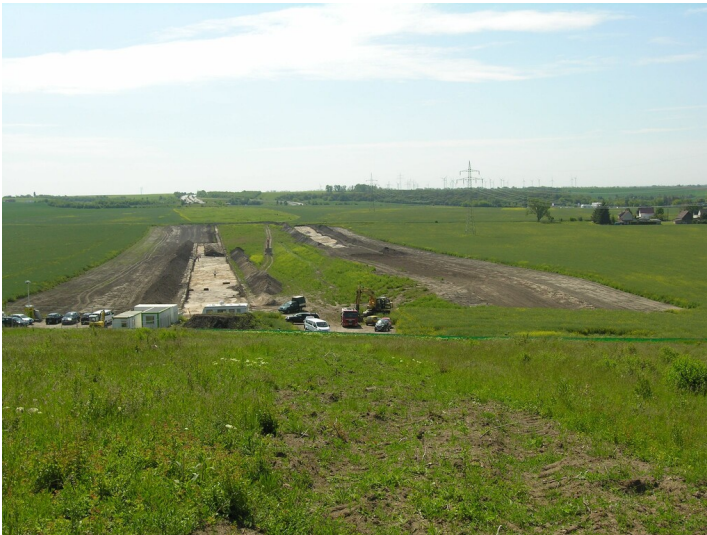
Abbaufeld der Grube Sophie I und II (nach 1845-ca. 1885) - Grabungsfläche über Bruchfeldern der Grube Sophie; Blick S; zukünftiger Verlauf der Autobahn Fotograf/Urheber: NAME FEHLT
