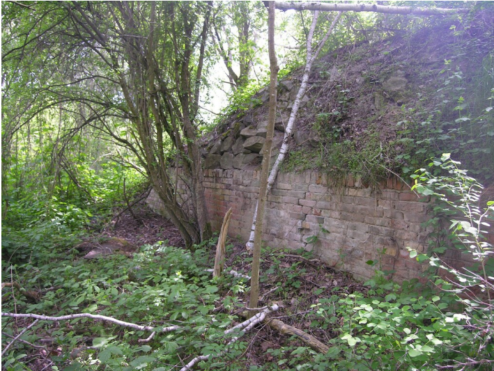
Damm einer Grubenbahn - Verloaderampe mit Bahndamm; Ziegelmauerwerk; Blick S Fotograf/Urheber: NAME FEHLT
