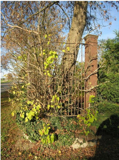
Zuckerfabrik Knauer - Zaun des Werksgarten; Blick N Fotograf/Urheber: NAME FEHLT
