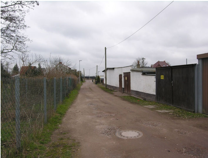
Tagesanlagen und Fabrik der Grube Delbrück - ehemaliges Fabrikgelände; Blick E Fotograf/Urheber: NAME FEHLT
