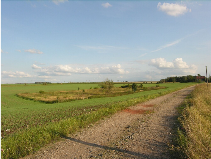
Bruchfeld der Grube Anna - Senkungserscheinungen über den Bruchfeldern, deutlich in Relation zu dem Weg auf einem Sicherheitspfeiler; Blick S Fotograf/Urheber: NAME FEHLT
