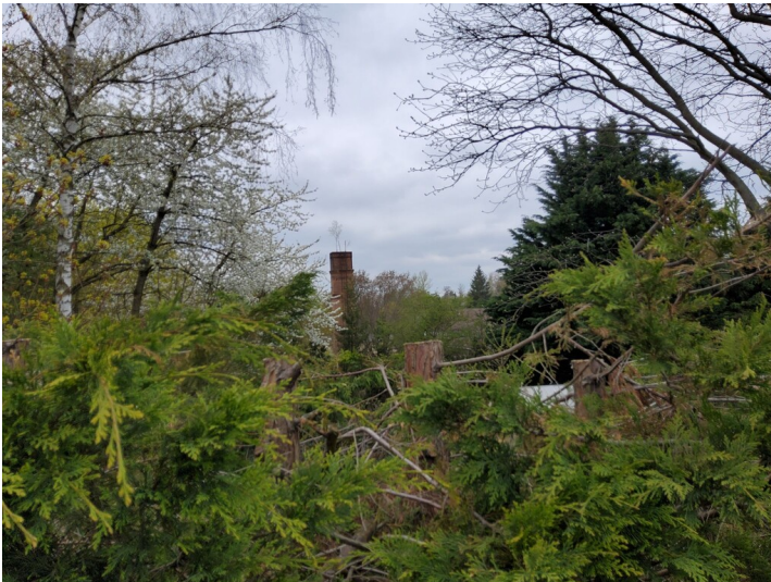
Schacht, Tagesanlagen und Fabrik der Grube Carl Ernst - Blick auf das Grubengelände Fotograf/Urheber: NAME FEHLT
