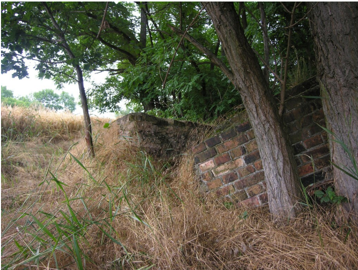
Albertschacht mit Tagesanlagen und Seilbahnstation - Mauerwerk und Fundamentreste; Blick NW Fotograf/Urheber: NAME FEHLT
