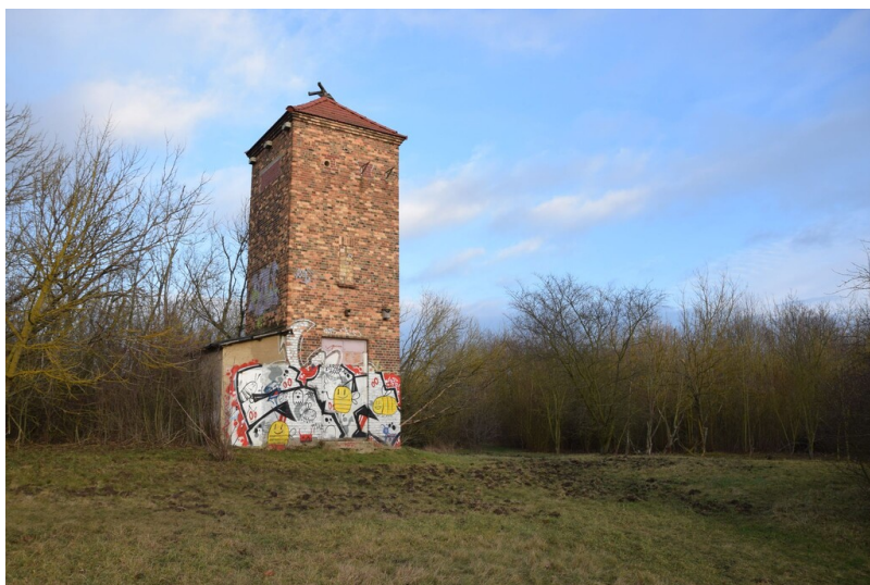
Trafostation - Transformatorstation, aufgenommen aus südöstlicher Richtung Fotograf/Urheber: NAME FEHLT
