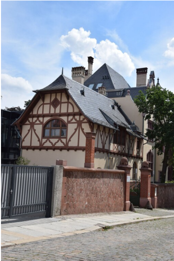
Villa Riedel - Straßenseite Rückansicht Fotograf/Urheber: NAME FEHLT
