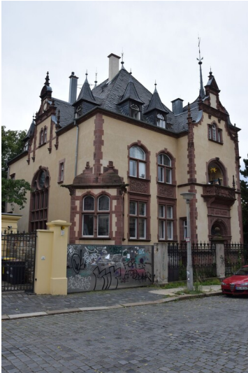
Villa Weise - Straßenansicht der Villa Weise Fotograf/Urheber: NAME FEHLT
