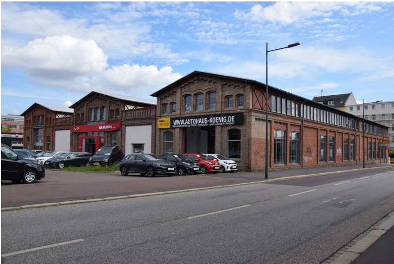
Maschinenfabrik Riedel & Kemnitz - Straßenansicht der ehemaligen Maschinbaufabrik Fotograf/Urheber: NAME FEHLT
