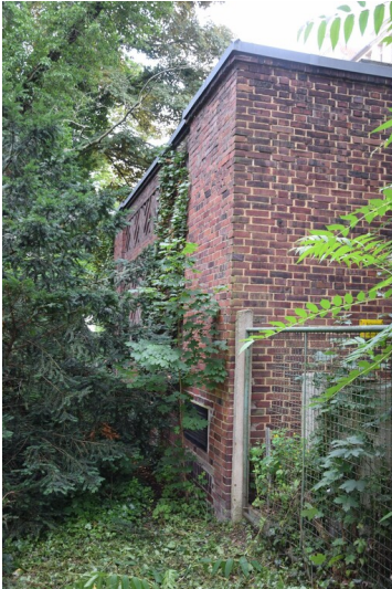
Transformatorstation Huttenstraße - Ansicht der Transformatorstation Fotograf/Urheber: NAME FEHLT
