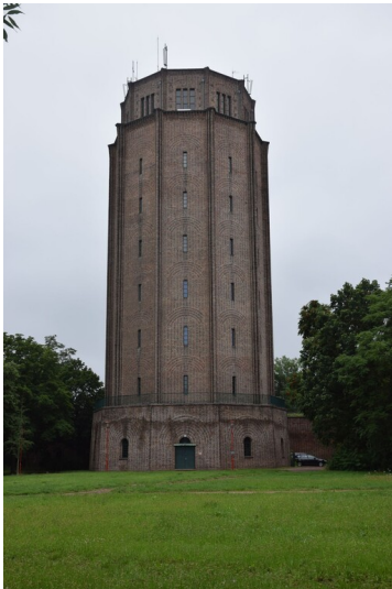
Wasserturm Süd / Umspannwerk - Wasserturm am Lutherplatz Fotograf/Urheber: NAME FEHLT
