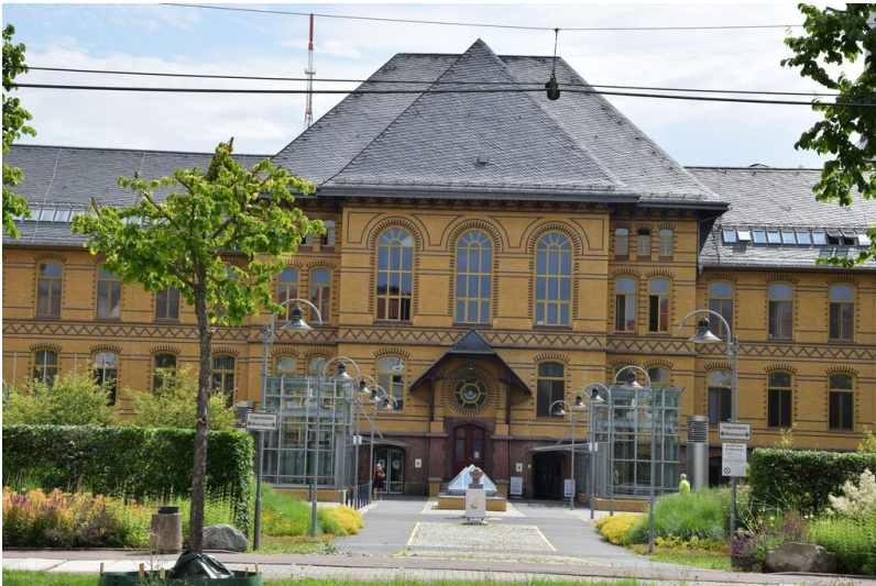
Krankenhaus Bergmannstrost - Ansicht des Haupteingangs Krankenhaus Bergmannstrost Fotograf/Urheber: NAME FEHLT
