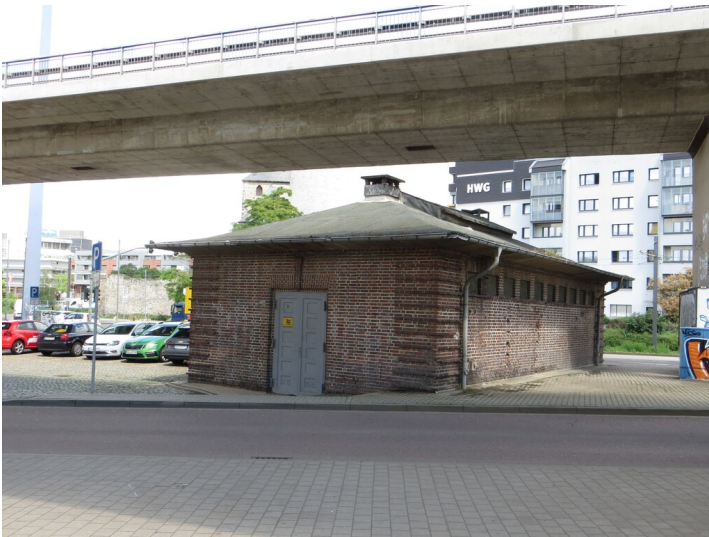
Trafostation Moritzzwinger - südliche Ansicht der ehemaligen Transformationsstation Fotograf/Urheber: NAME FEHLT
