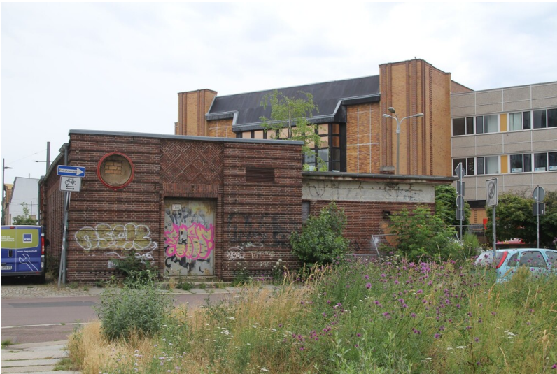
Transformatorstation, Tankstelle und Bedürfnisanstalt - Straßenansicht der Transformatorstation Fotograf/Urheber: NAME FEHLT
