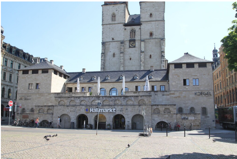
Umspannwerk Hallmarkt Fotograf/Urheber: NAME FEHLT
