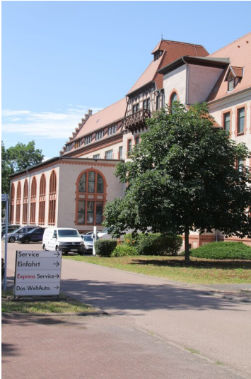
Elektrizitätswerk Holzplatz - Vorderansicht Fotograf/Urheber: NAME FEHLT
