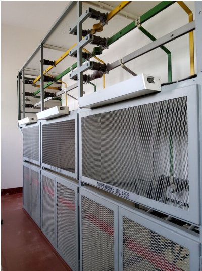
Techniksammlung Stadtwerke Halle - Sammelschienen Fotograf/Urheber: NAME FEHLT
