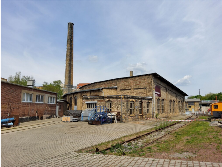
Lokschuppen Bahnbetriebswerk Personenverkehr BWP - Blick nach Norden Fotograf/Urheber: NAME FEHLT
