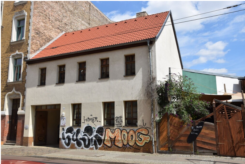
Zweigstelle Landesamt für Geologie und Bergwesen - Straßenansicht der ehemaligen Zweigstelle des Landesamt für Geologie und Bergwesen Fotograf/Urheber: NAME FEHLT
