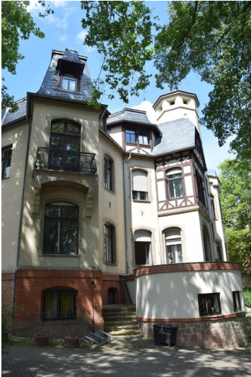
Brummesche Villa - Straßenseitige Aufnahme der ehemaligen Villa des Zuckerfabrikanten Brumme Fotograf/Urheber: NAME FEHLT
