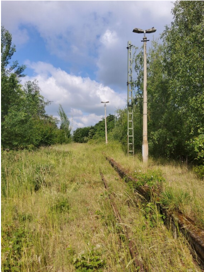
Bahnhof Dölau - Aufgegebene Bahntrasse unmittelbar westlich des Bhf Halle-Dölau, Blick nach Westen Fotograf/Urheber: NAME FEHLT
