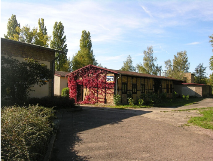
Werkstattgebäude der Großtagebaue von der Heydt und Bruckdorf - ein Lagergebäude; Blick W Fotograf/Urheber: NAME FEHLT
