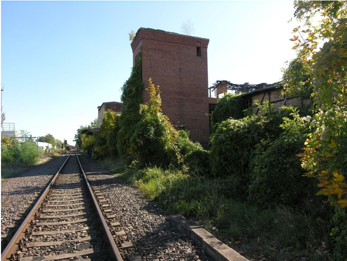
Papierfabrik Radewell - Papierfabrik Radewell, Verladestation; Blick E Fotograf/Urheber: NAME FEHLT
