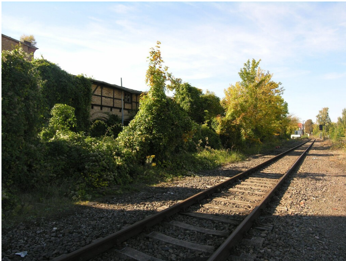
Anschlussbahn zur Presse der Grube Hermine Henriette I - die Bahnstrecke bei Radewell, Richtung Ammendorf; Blick W Fotograf/Urheber: NAME FEHLT
