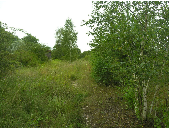
Damm einer Kohlebahn des Großtagebaus von der Heydt - Bahntrasse, Damm; Blick W Fotograf/Urheber: NAME FEHLT
