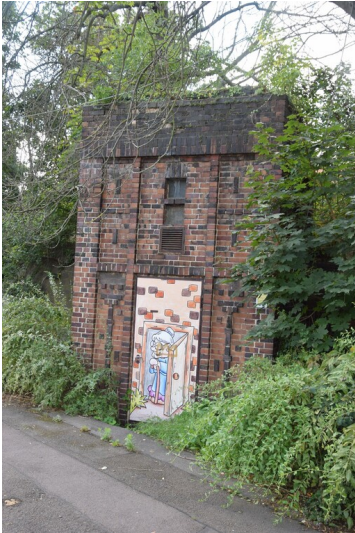
Transformatorstation Ammendorf/Beesen - Straßenansicht der ehemaligen Transformatorstation Fotograf/Urheber: NAME FEHLT
