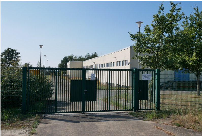
Umspannwerk Tagesanlagen Cottbus-Nord Fotograf/Urheber: Kaja Boelcke
