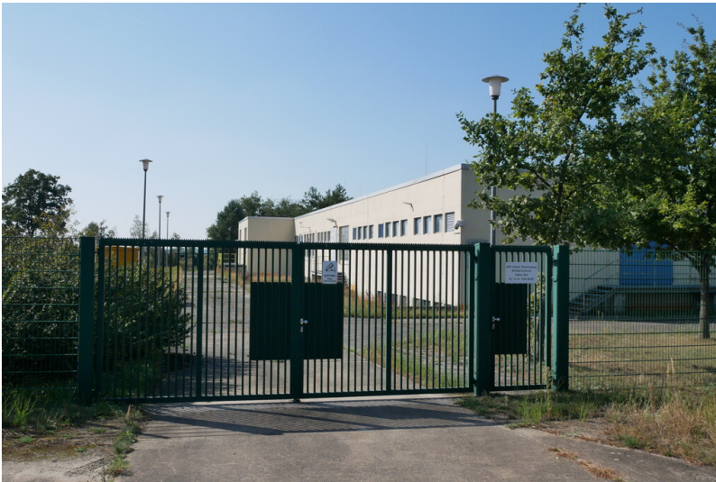
Umspannwerk Tagesanlagen Cottbus-Nord Fotograf/Urheber: Kaja Boelcke
