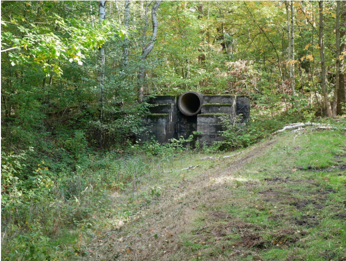
Überlaufbauwerk Fotograf/Urheber: Franz Dietzmann
