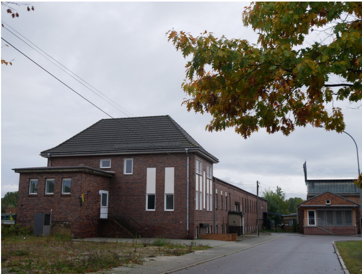
Schipkau Zentralwerkstatt Fotograf/Urheber: Tanja Trittel
