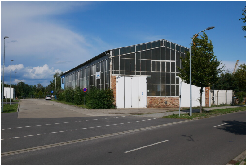
Braunkohlenbohrungen und Schachtbau Welzow Fotograf/Urheber: Kaja Boelcke
