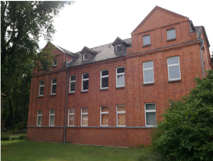
Beamtenwohnhaus Eintracht Braunkohlenwerke und Brikettfabriken AG Fotograf/Urheber: Kaja Boelcke
