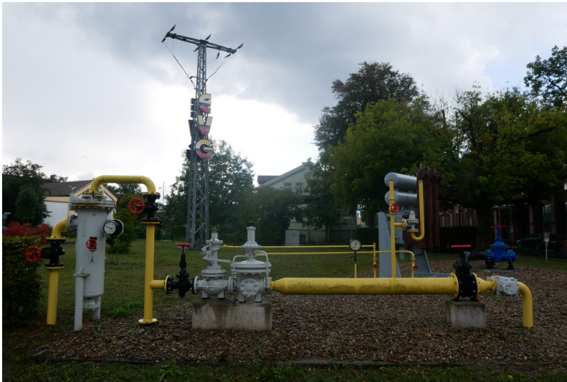
Gaswerk Guben Fotograf/Urheber: Kaja Boelcke
