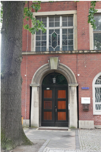
Textilfabrik Lehmann & Richter Fotograf/Urheber: Kaja Boelcke
