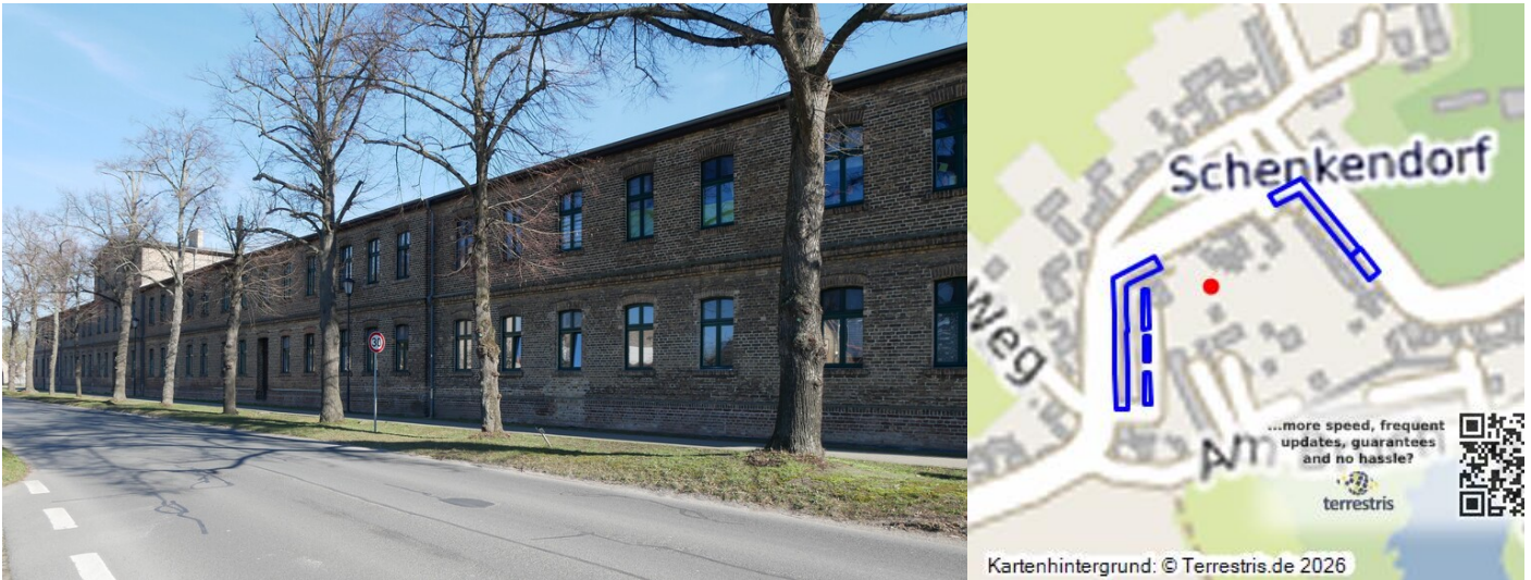
Reihenwohnhäuser Grube Centrum Fotograf/Urheber: Franz Dietzmann
